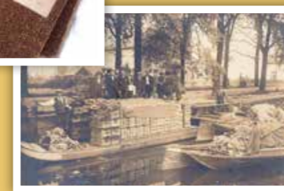
1925 Volgeladen veilingsschuiten aan de loswal op de Oostlaan
