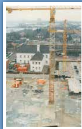
Bouw van de Ackershof vanuit de hoogwerker
